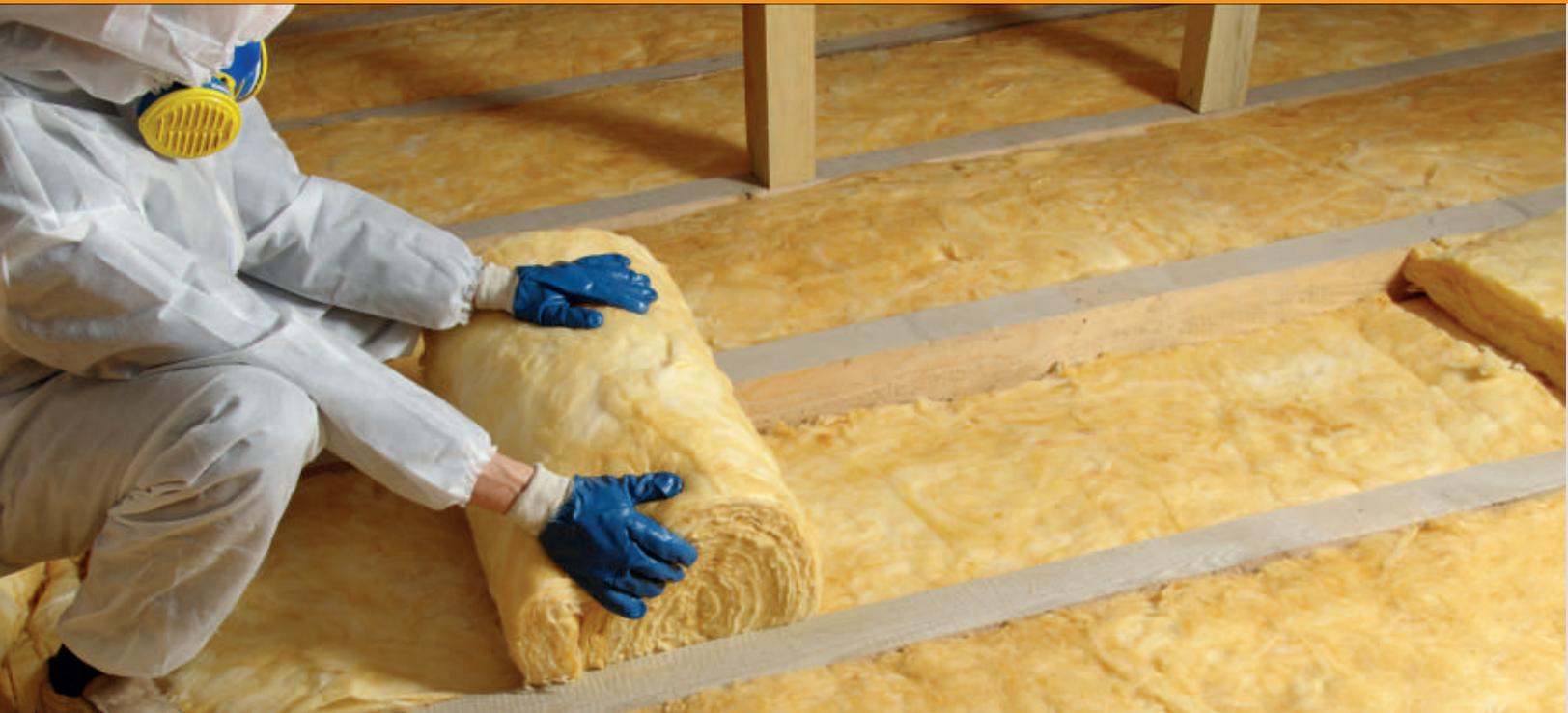
Lana de vidrio, es un fieltro constituido por fibras entrelazadas producto de un proceso de fusión a altas temperaturas de áridos de sílice y una mezcla de calcio molido, que impiden el paso de corrientes de aires y posee un alto coeficiente o resistencia al calor. Posee una gran capacidad de resiliencia lo que le permite recuperar su forma original después de soportar cargas físicas.
